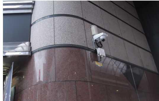
防犯カメラを新設【写真①】
