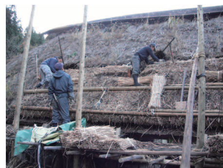
屋根を修理する様子
