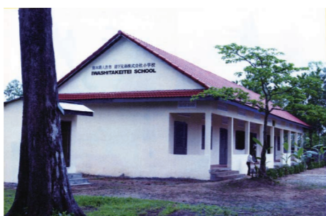
建設した小学校【写真③】
