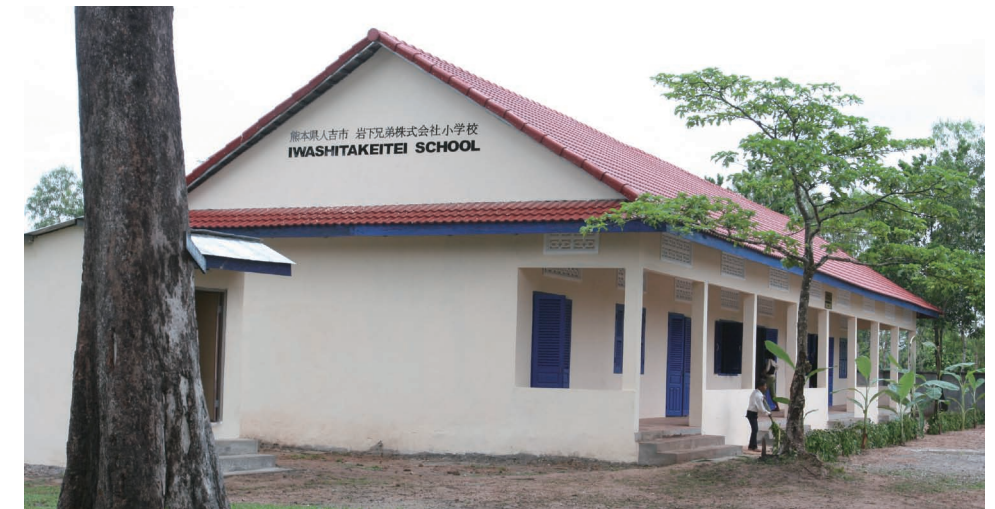
2010年7月に完成した小学校
