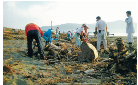
川南伊倉浜海岸の流木撤去作業
