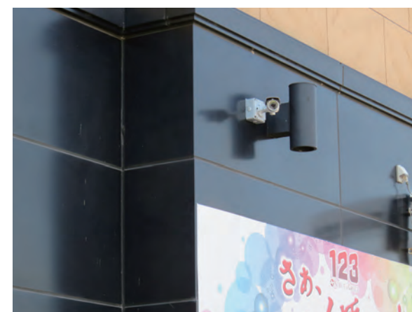
ホールに設置された防犯カメラ
