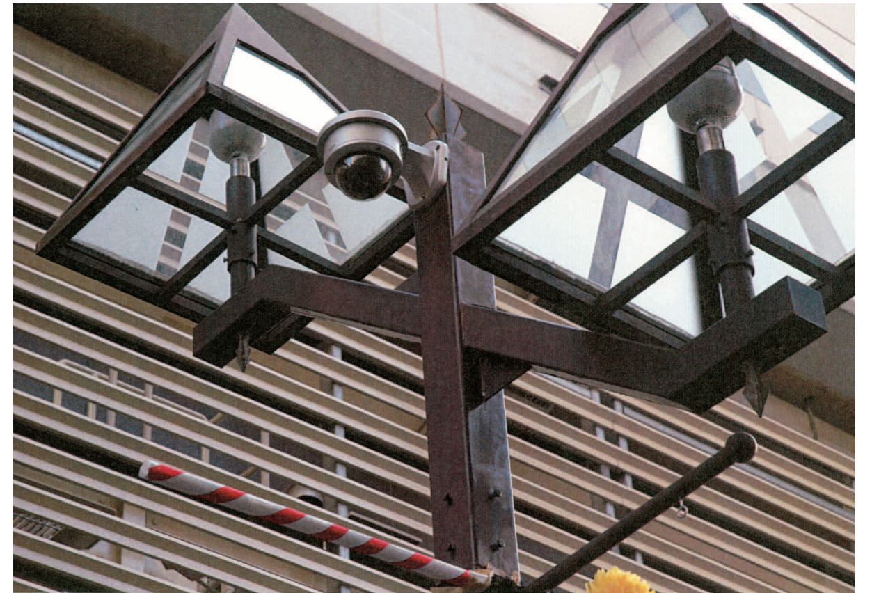
多摩センター駅前に設置された第1号機の防犯カメラ
