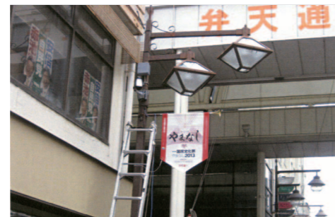
設置された防犯カメラ [写真②]
