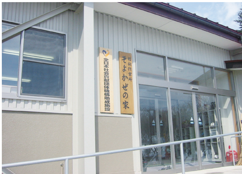
施設の外観：改装し快適な生活空間に生まれ変わった
