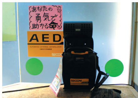
ホール内に設置されたAED
