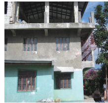
工事を中断したエラブ校
